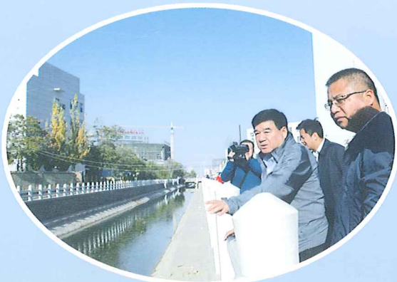
图为调研二排沟综合治理情况
